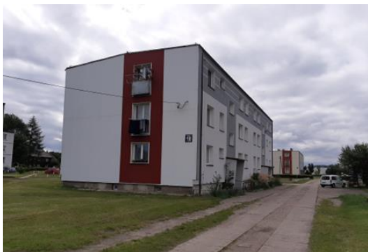
Zastąpienie kotłowni węglowej gruntowymi pompami ciepła w 14 budynkach
