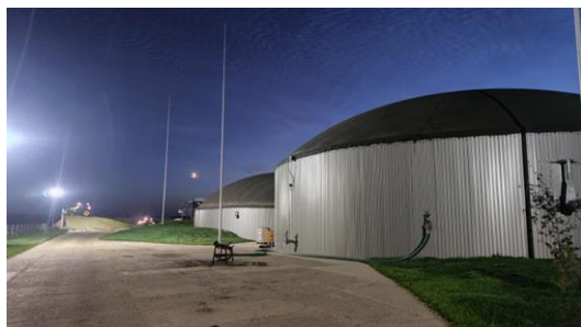
Elektrownia biogazowa o mocy 500 kW
